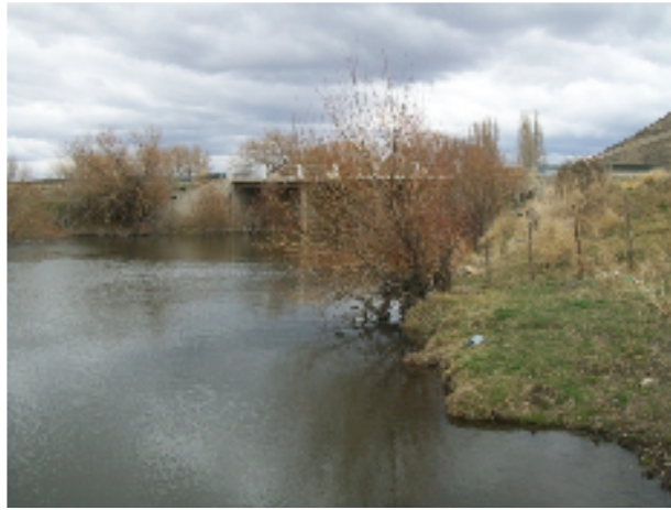
Fig. 5: Río Tecka “Puente Ruta 40”
